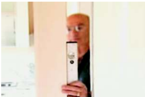
Faza 8 sprawdzamy pion oraz poziom drzwi
