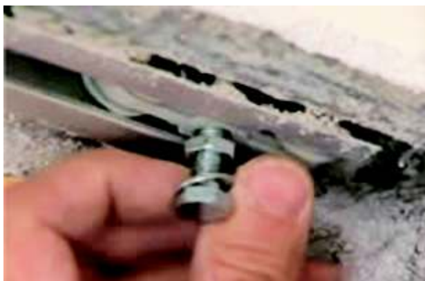
Faza 3 wózki wkładamy do aluminiowej prowadnicy
