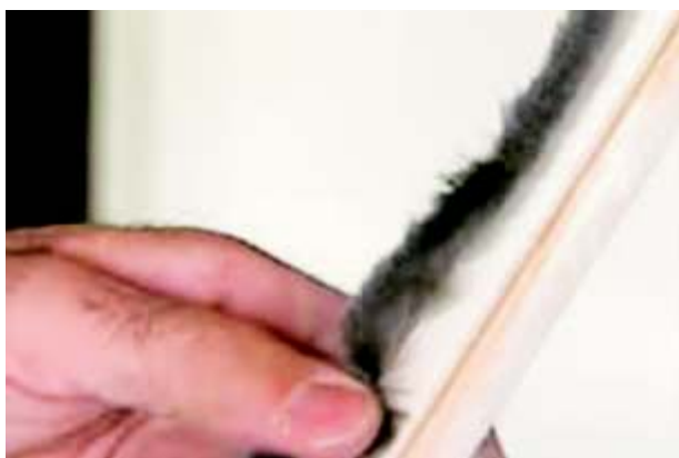
Faza 12 do słupków pionowych ościeżnicy oraz górnej belki mocujemy szczotki.
