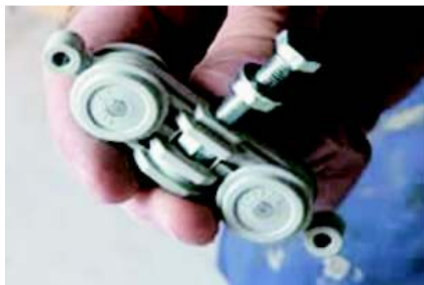
Faza 2 do wózka wkładamy śrubę wraz z dwiema nakrętkami
