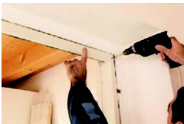
Faza 18 całość skręcamy lub montujemy za pomocą kleju montażowego
