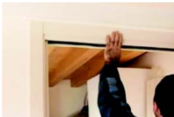
Faza 20 montujemy opaski maskujące do ościeżnicy za pomocą kleju montażowego
