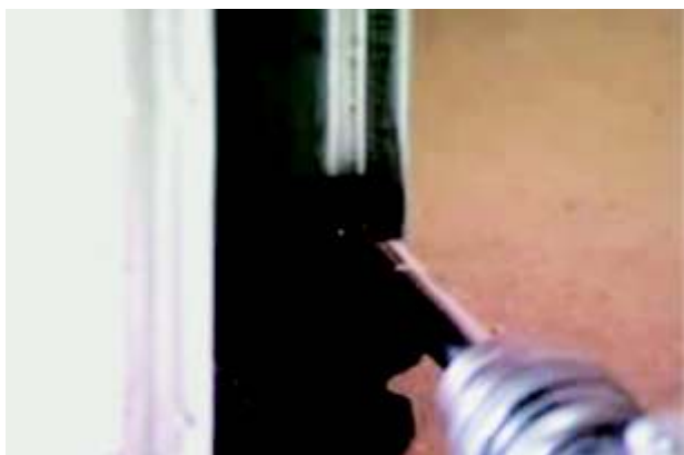
Faza 5 zmontowany prowadnik przykręcamy do kasety.
