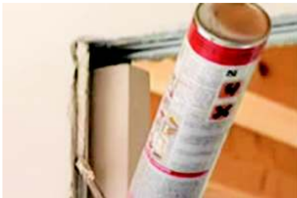
Faza 14 klejem montażowym mocujemy słupek pionowy ościeżnicy.
