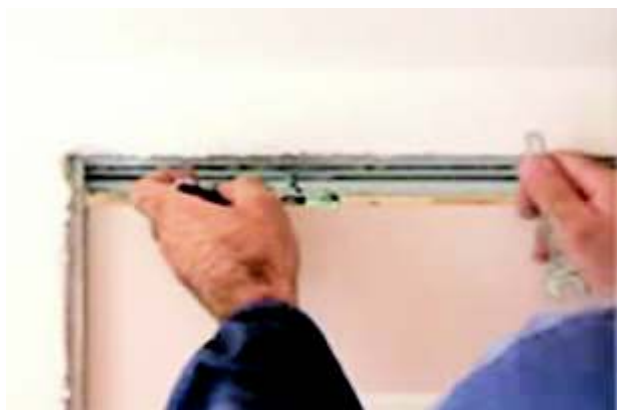
Faza 9 w razie potrzeby jeszcze raz ustawiamy drzwi.
