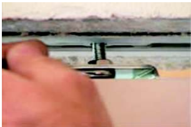
Faza 7 regulujemy ustawienie drzwi
