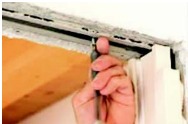
Faza 13 przykręcamy blokadę wózka przedniego
